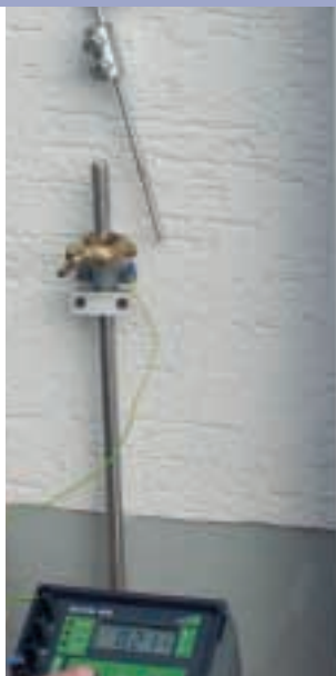
Měření odporu uzemnění
